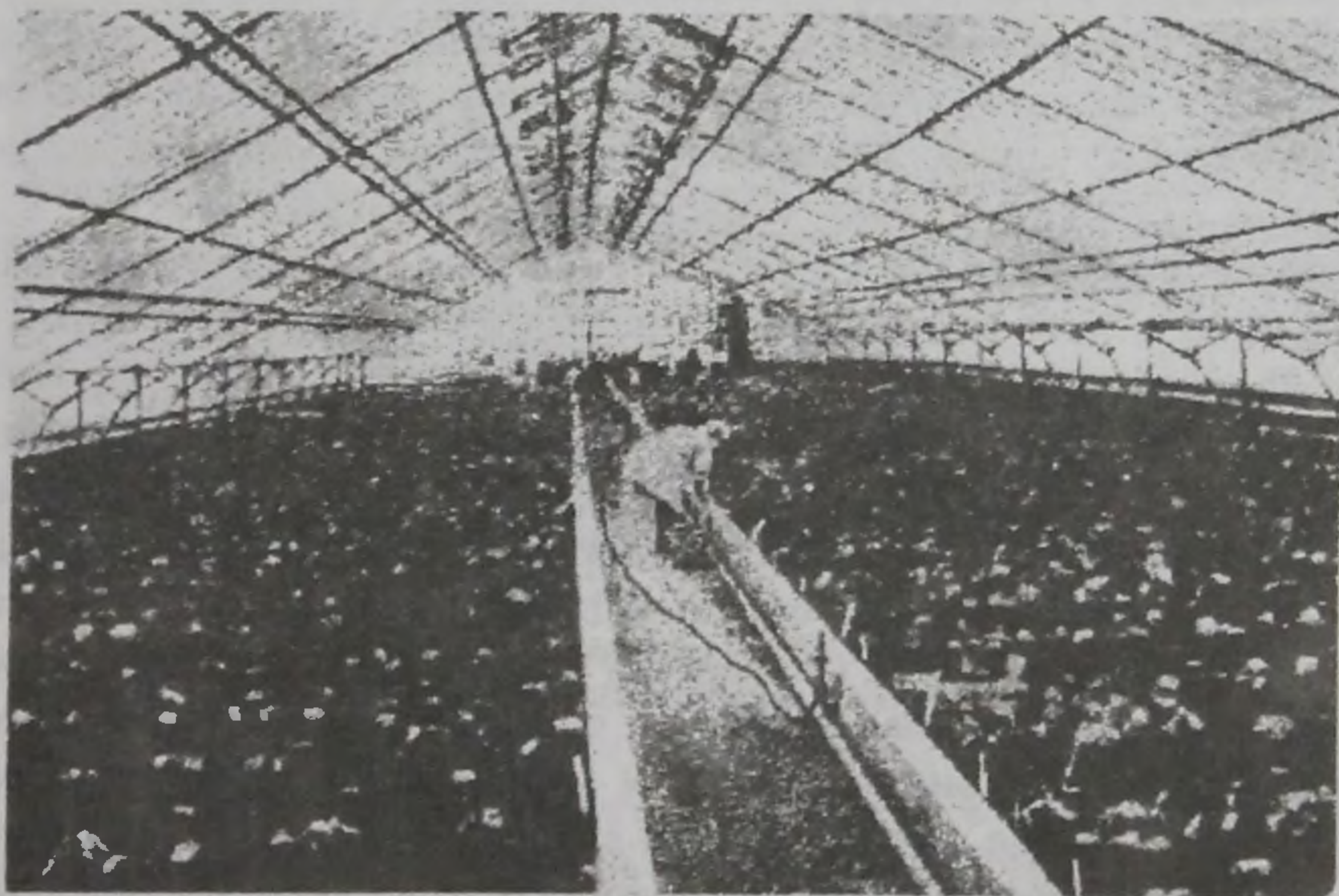
Рис. 12. Внутренний вид ангарной теплицы ( площадь 71,3 х 14)
