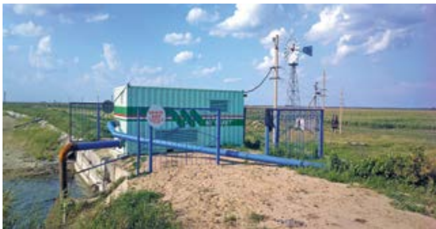
Фото 1. Автоматическая контейнерная насосная станция ШН-КЕЛЕТ на объекте
