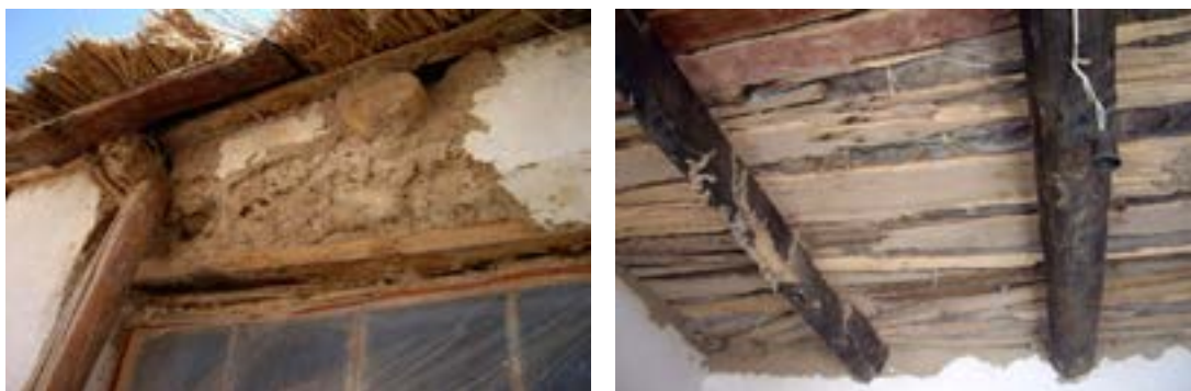
Рисунок 1. Повреждения термитами жилого дома в г. Хиве (2009 г.): (I) - стропила из тополя повреждения термитами, (II) - стропила из сосны не тронутая насекомыми.
